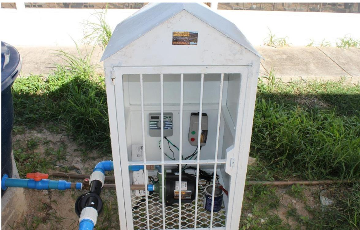
Figura 2A – Conjunto motobomba de irrigação automática com temporizador integrado.
