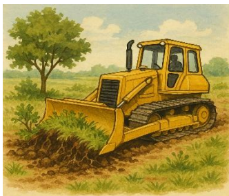
Remoção da camada superficial dos solos ao retirar vegetação com trator de esteira.
